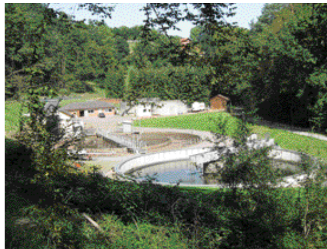
Die Schautafel der Kläranlage Heimbuchenthal.
